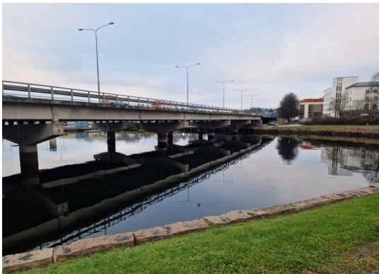
Figur 3-19: E18 på bru over Sandviksbukta (foto: Bærum kommune).
